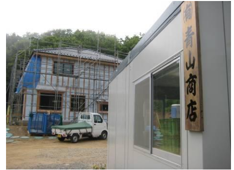
現在、建設中のご新居 (8月完成予定)
